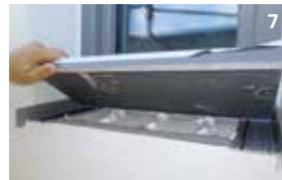
7. Die Fensterbank auf das fertig beschichtete (z. B. mittels Dichtschlemme) und nach außen geneigte Parapet versetzen. Befestigung erfolgt durch raupenförmig angeordnetem Montagekleber in Abständen von ca. 100 mm (in Neigungsrichtung). **Fuge zwischen Fensterbank und Parapet nicht abdichten!**
