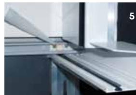
5. Eckbereich bei Ausklinkung mit Silikonputzen abdichten
