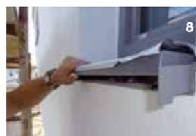
8. Fensterbank einsetzen. Dabei die Fensterbank kräftig bis auf Anschlag in das Anschlussprofil drücken. Kontrolle: Fensterbank und Slide - Abschlüsse müssen vorne etwa bündig sein.
