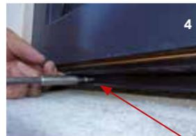
4. Slide - Abschluss System inkl. eingestecktem Anschlussprofil mittig zum Fenster am Basisprofil bzw. Blendrahmen montieren. Profil leicht nach oben gegen den Fensterrahmen drücken und gerade ausrichten.
