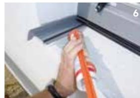
6. Slide - Abschlüsse am Parapet verkleben (z. B. mit helopal Fensterbank Montagekleber MS) und fixieren. Auf rechten Winkel zum Fenster und auf 5° Gefälle nach vorne achten!
